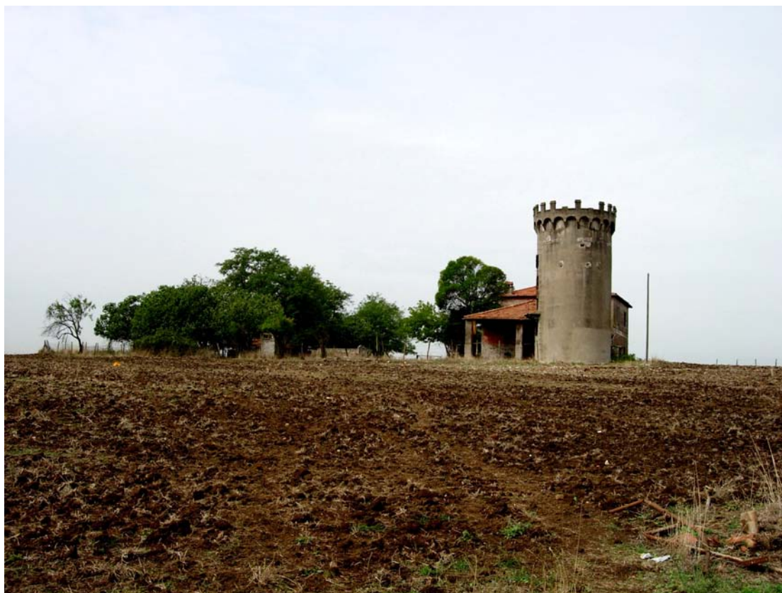
Il Casale del Marmo Nuovo della Tenuta Massara interno al perimetro della proposta di cessione al Comune di Roma
